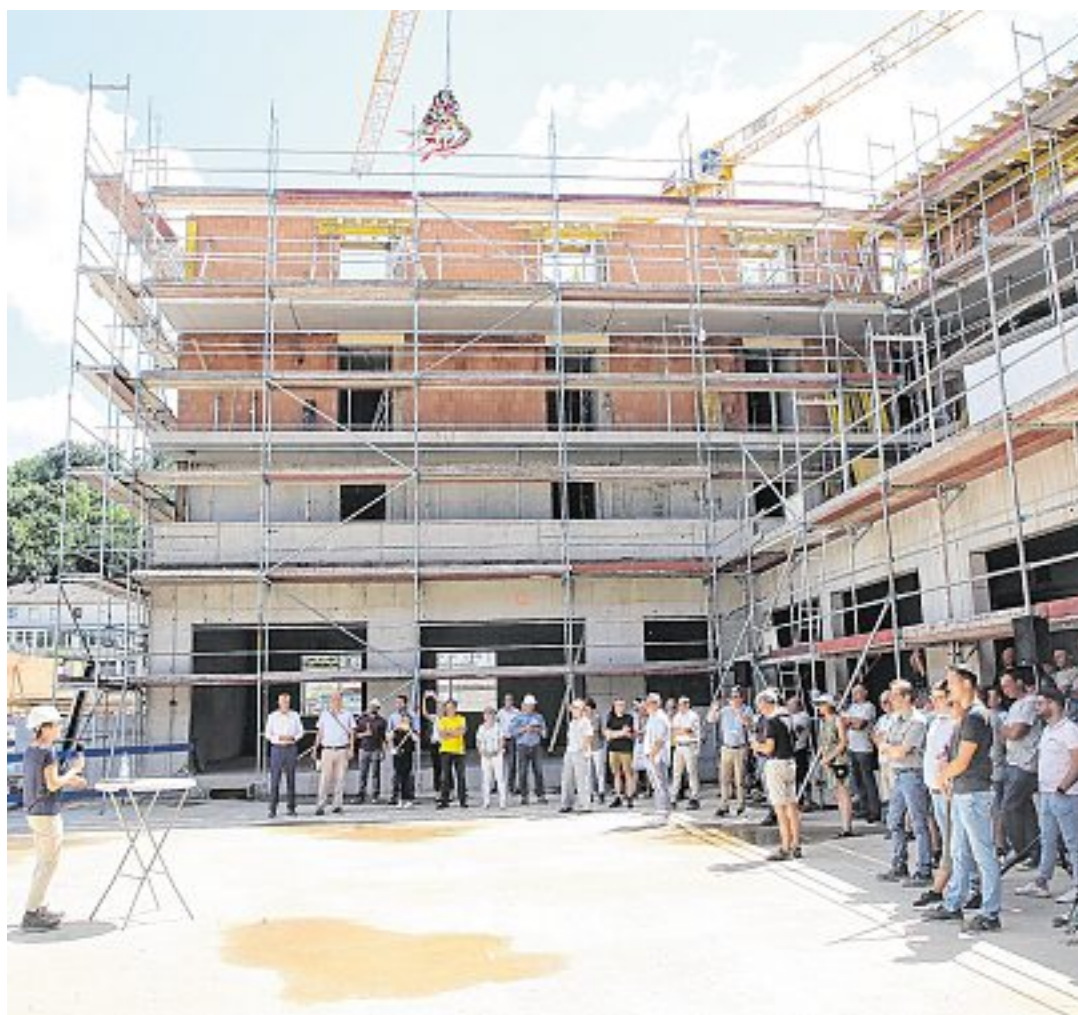
Antje Durach, technische Geschäftsführerin der Landes-Bau-Genossenschaft, am Rednertisch beim Richtfest für das Projekt „Wohnen in den Fehrle-Gärten“.
